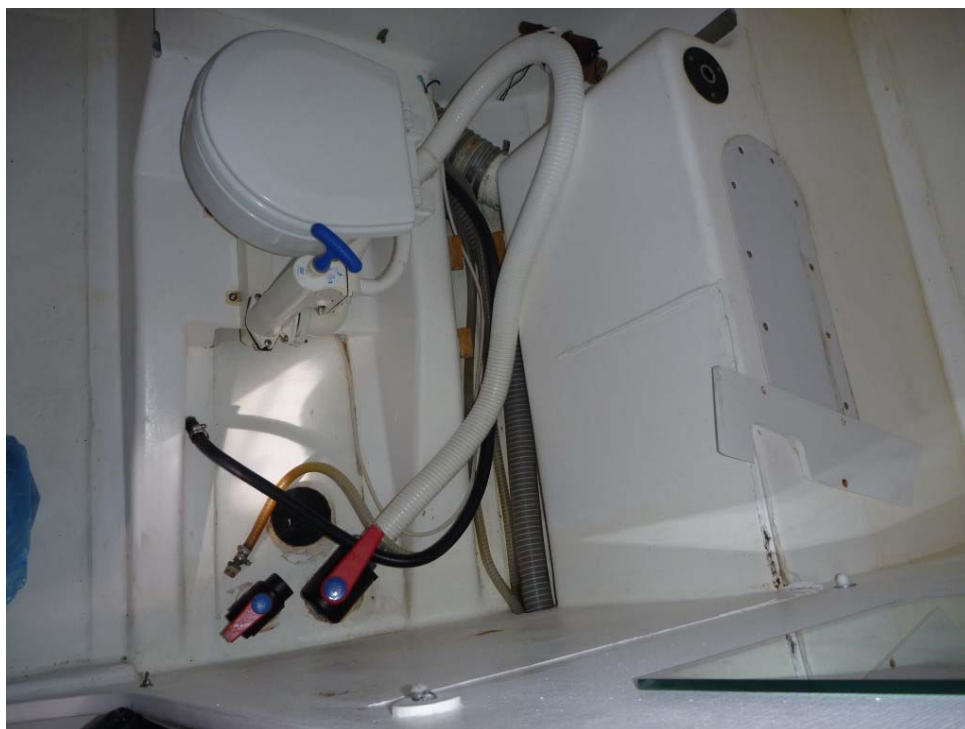
7-Cantiere Pogo Structure –Scarico Wc
